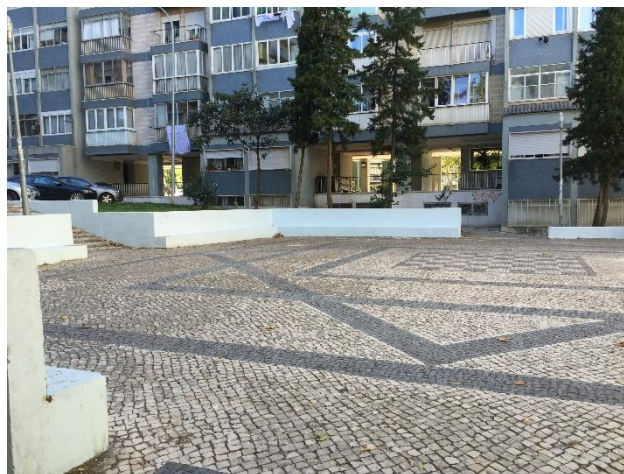
Reabilitação de muros na Rua Mariano Pina
