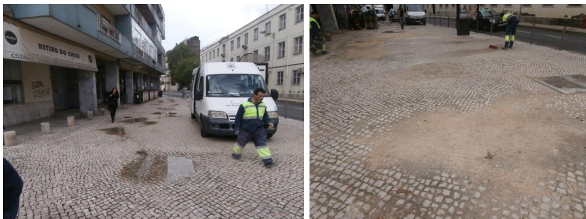
Estrada de Benfica (Antes / Depois)
