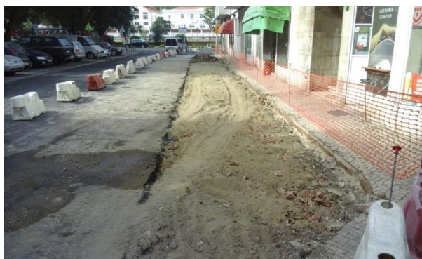
Reperfilamento da Travessa de São Domingos de Benfica
