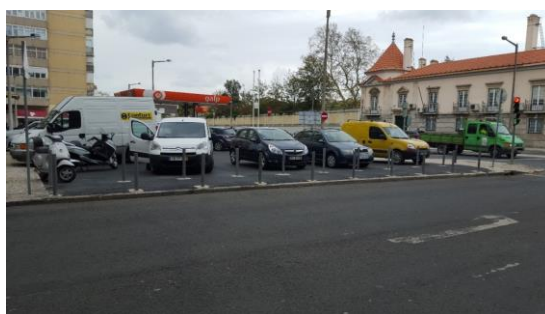
Colocação de pilaretes em zona pedonal na Rua Lúcio de Azevedo.
