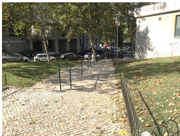
Colocação de corrimão na Rua Augusto Pina
