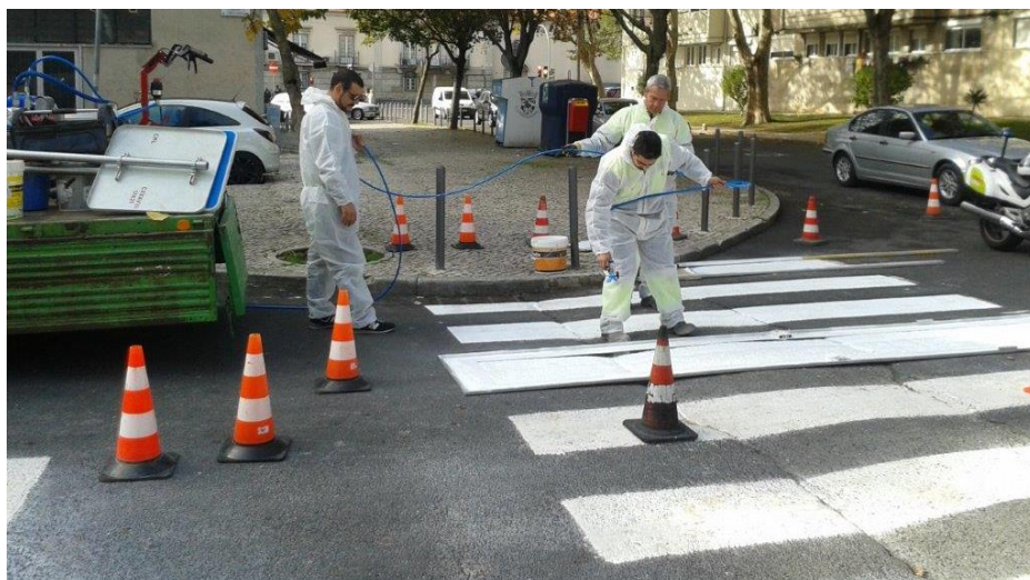
Pintura de passadeira na Rua Ginestal Machado
