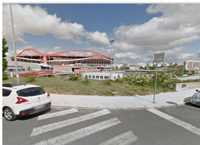
Rua António Alçada Baptista (Antes)
