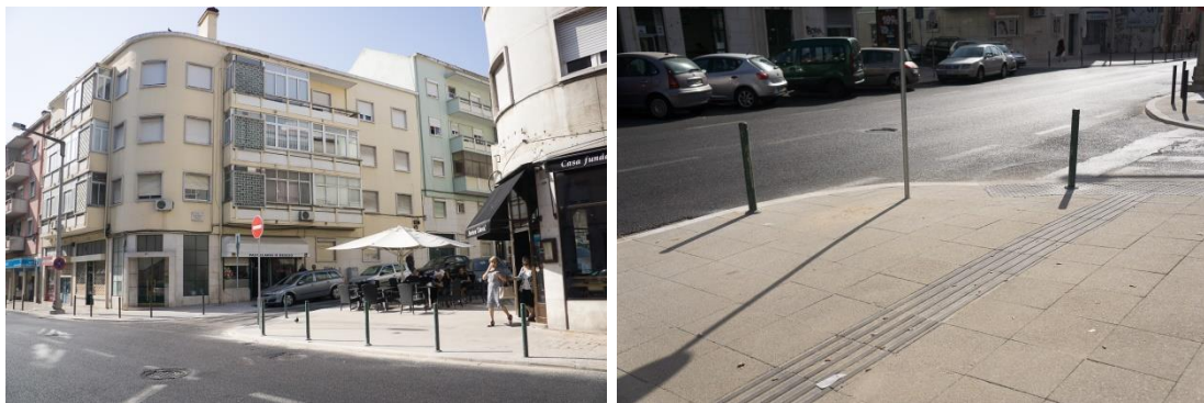
Estrada de Benfica c/ Rua Dr. Mascaranhas de Melo (Rebaixamento de passadeira)
