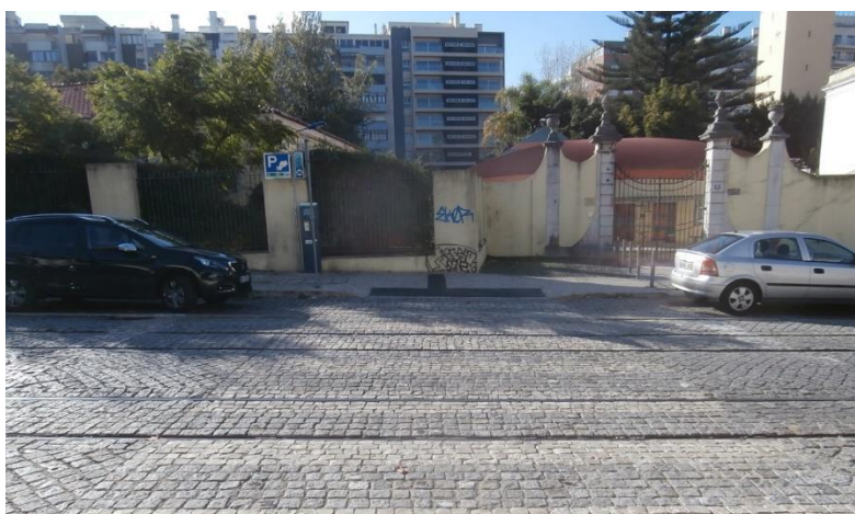
Nivelamento de Passadeiras e colocação de piso tátil Rua Professor Lima Basto
