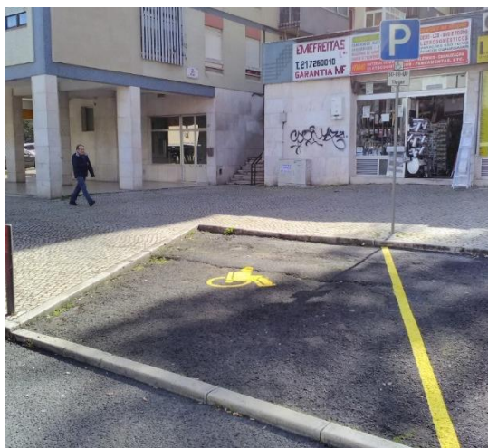
Pintura de lugar de estacionamento na Estrada da Luz
