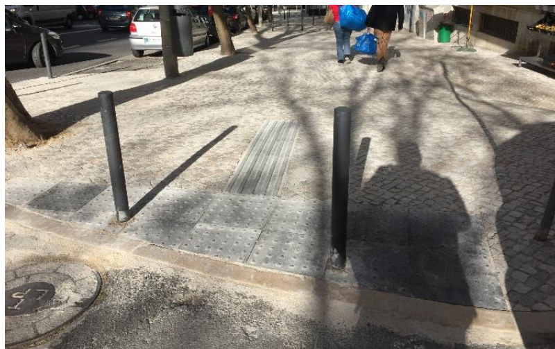
Nivelamento de Passadeiras e colocação de piso tátil na Rua dos Soeiros
