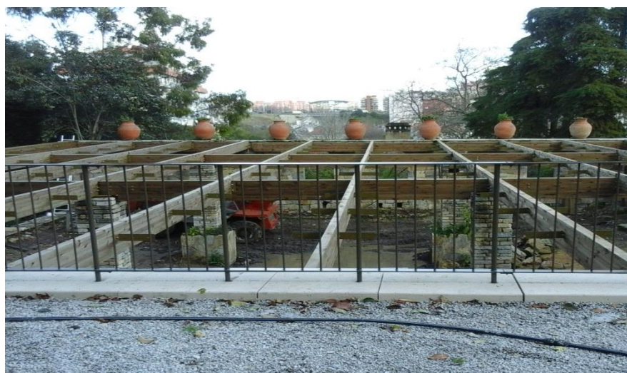
Cobertura da estufa no Parque Bensaúde
