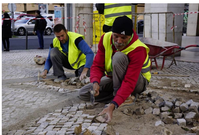
Nivelamento de Passadeiras e colocação de piso tátil na Rua dos Soeiros
