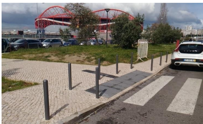
Colocação de pilaretes na Rotunda das Oliveiras junto ao Alto dos Moinhos
