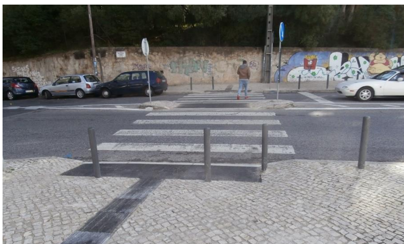
Nivelamento de Passadeiras e colocação de piso tátil Rua João de Freitas Branco
