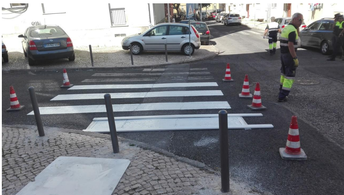
Pintura de passadeira na Rua José Carlos Sá da Silveira (Bairro das Furnas)
