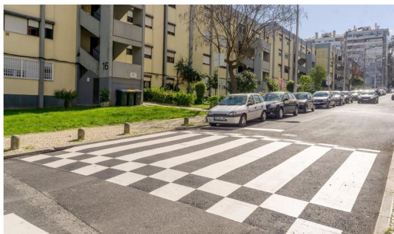
Nivelamento de Passadeiras na Rua Mateus Vicente
