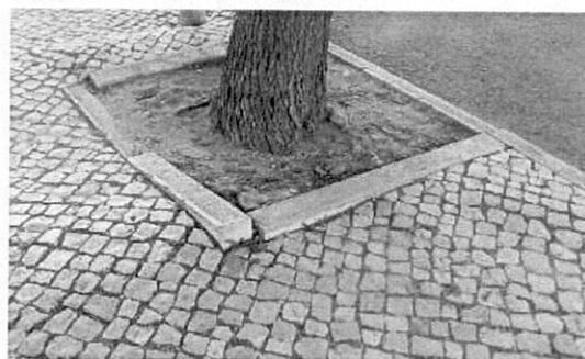
Reparação de Caldeiras – Rua Frei Luis Granada
