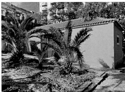
Requalificação das Instalações Sanitárias – Parque Bensaúde
