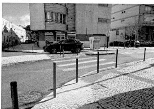
Colocação de pilarete – Av a Conselheiro Barjona de Freitas c/ Estrada de Benfica
