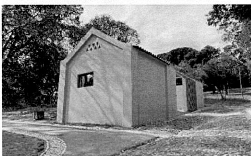
Requalificação da Portaria e Arrumos – Parque Bensaúde
