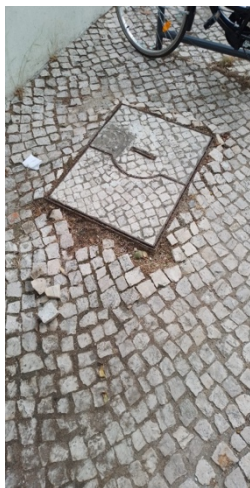
Reposição de calçada e reconstrução de caixa
