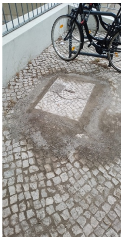
Reposição de calçada e reconstrução de caixa
