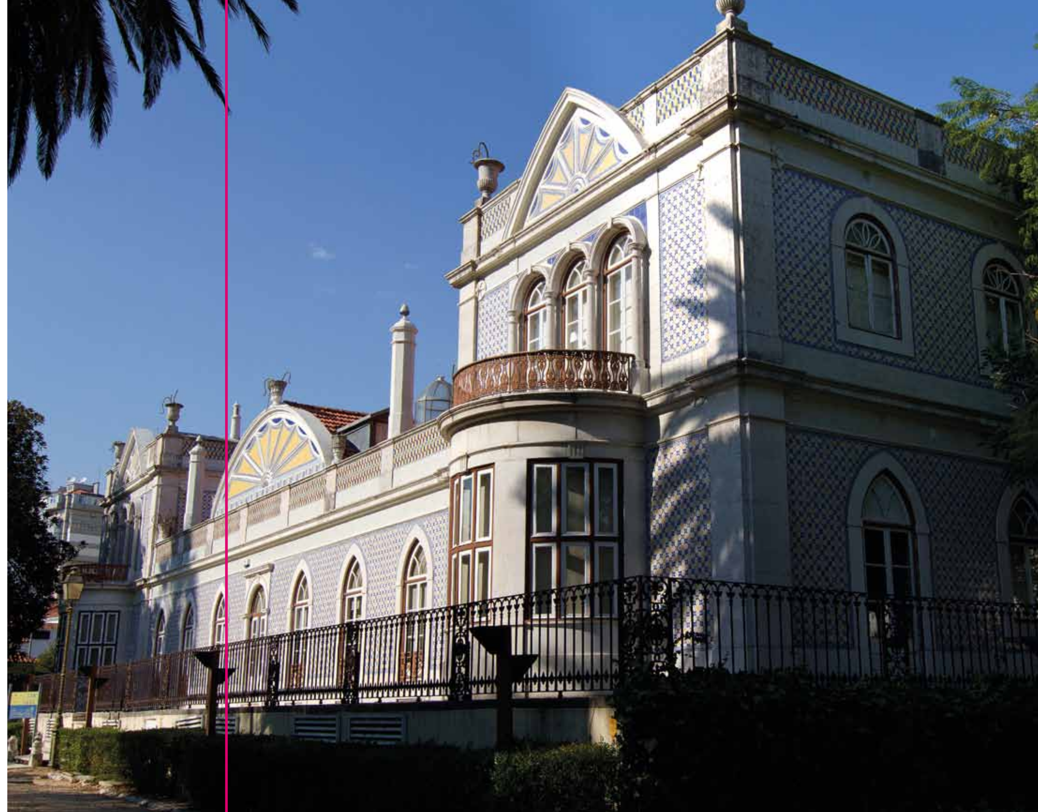
Fachada do Palácio Beau Séjour
