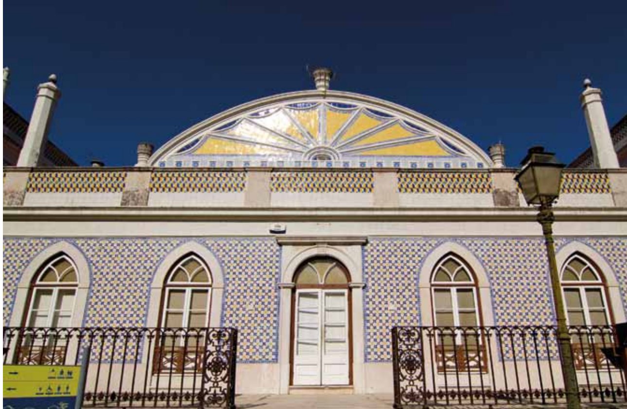
Fachada do Palácio Beau Séjour, com revestimento azulejar muito interessante
