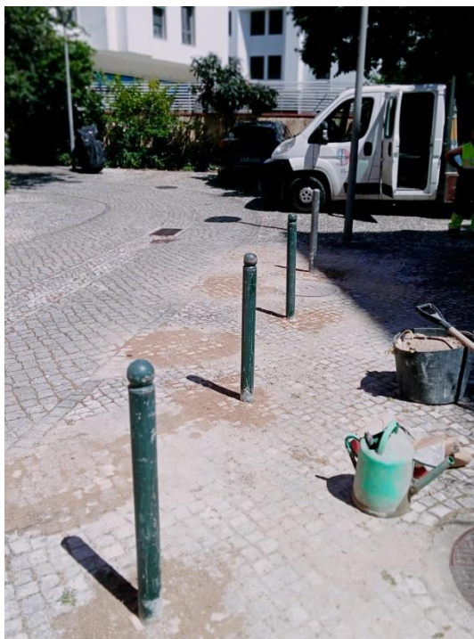
Fixação de Pilaretes no Bairro Grandela
