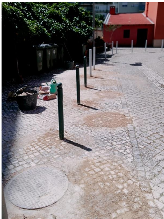
Fixação de Pilaretes no Bairro Grandela
